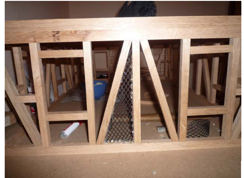
Abbildung 7: Gitter für den Putz
