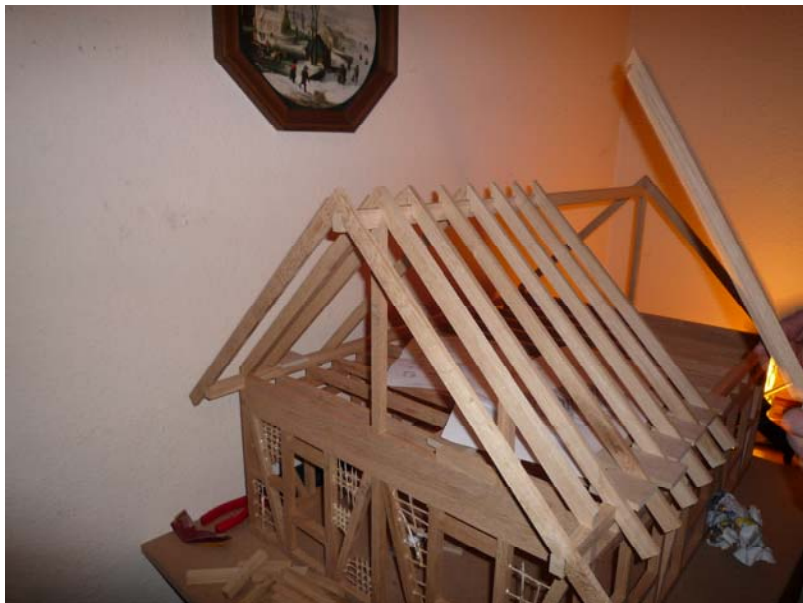
Abbildung 10: Aufschlag der Sparren
