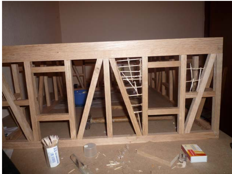
Abbildung 5: Holzgeflecht der einzelnen Gefache
